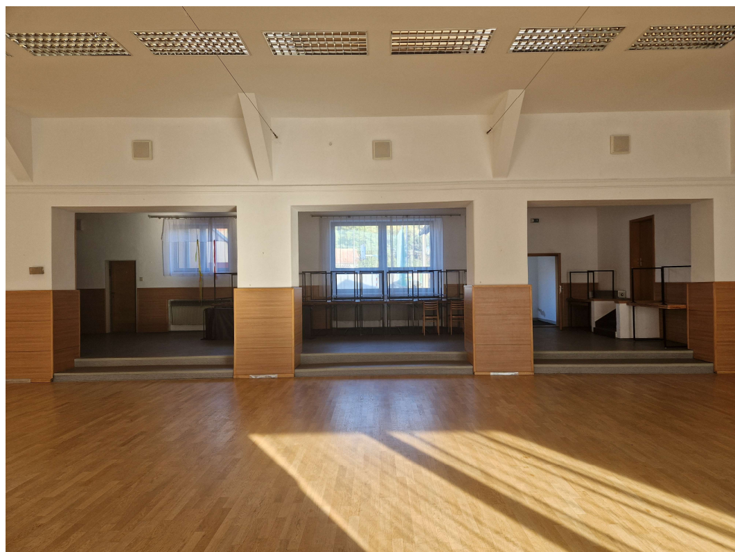
Obr. 21 – Stávající stav, pohled ze sálu do předsálí.
