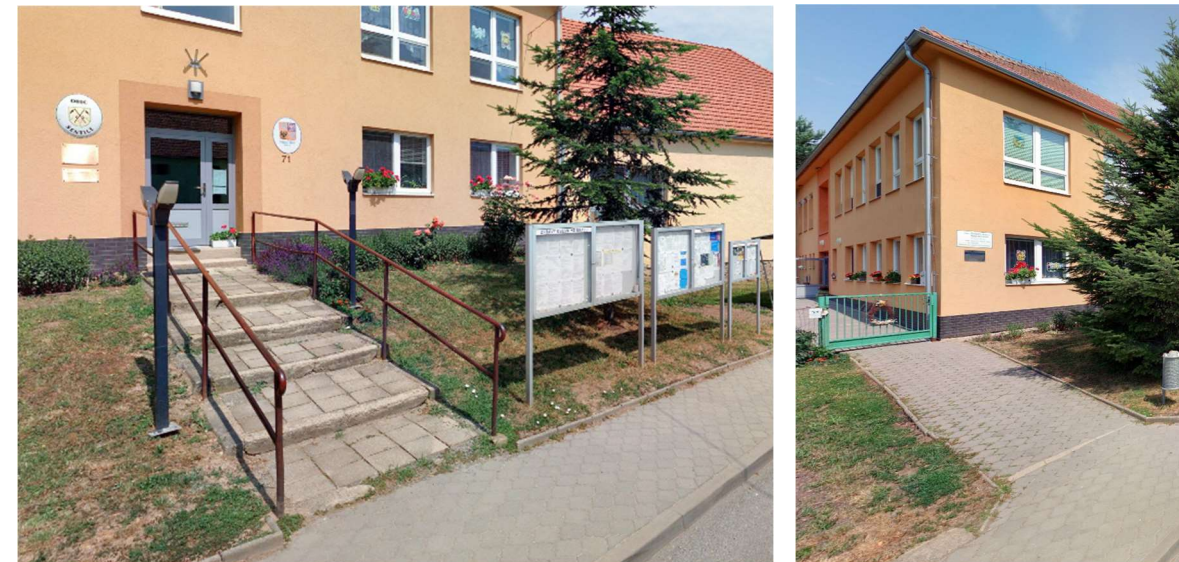
Obr. 29, 30 – Stávající stav vstupu do budovy Obecního úřadu z hlavní ulice, bezbariérový vstup do ZŠ.
