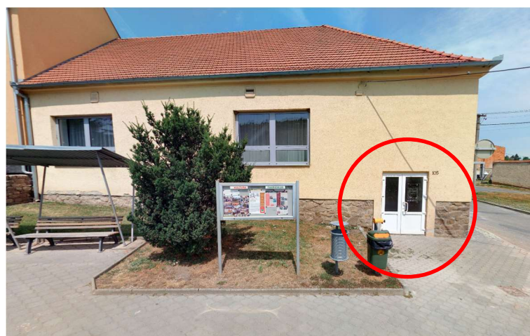
Obr. 13 – Stávající vstup do Kulturního domu z hlavní ulice.
