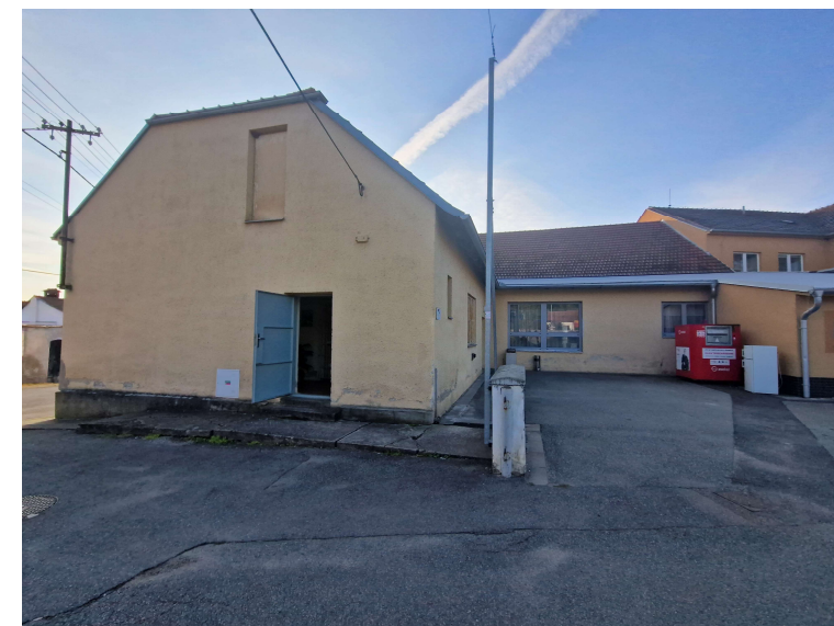
Obr. 14 – Stávající stav vnitrobloku v části Kulturního domu.
